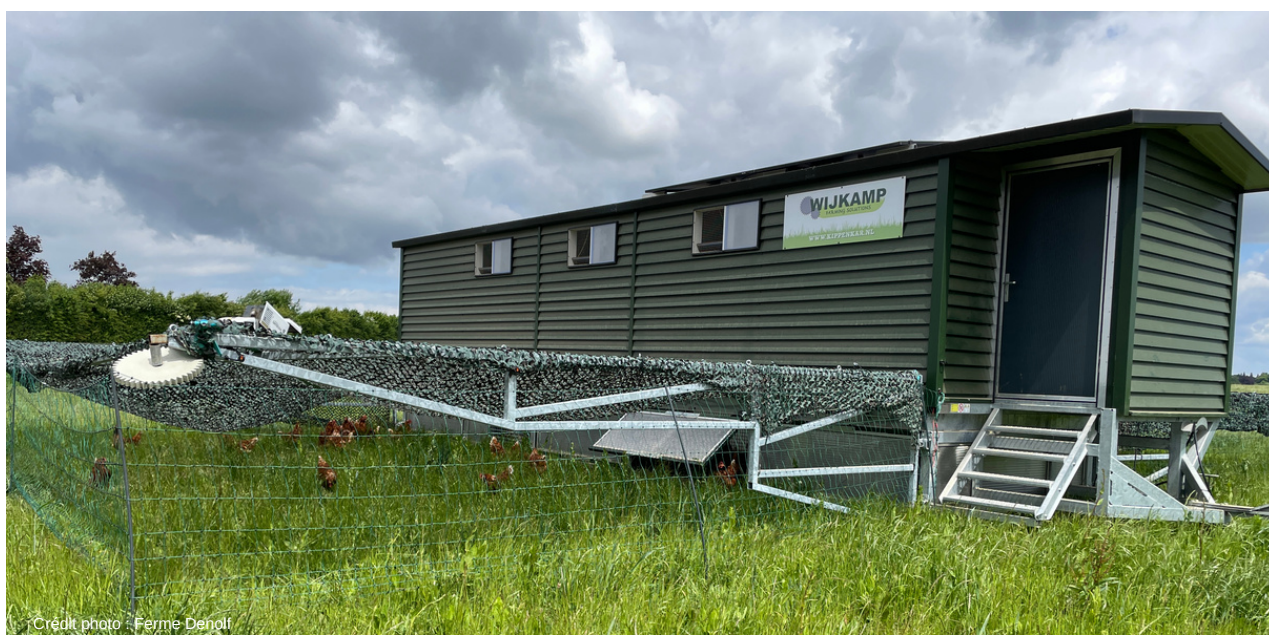
Installation Wijkamp visible à la ferme Denolf.
