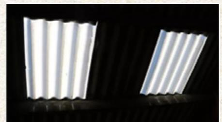
Figure 3 : Peinture d'ombrage appliquée sur translucides pour réduire le rayonnement (Source : BIGNON E., Réussir lait, 10 octobre 2023)
