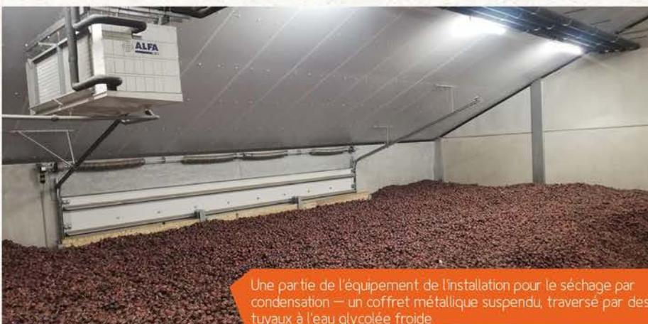
Une partie de l'équipement de l'installation pour le séchage par condensation – un coffret métallique suspendu, traversé par des tuyaux à l'eau glycolée froide
