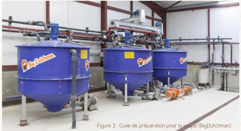
Figure 2 : Cuve de préparation pour la soupe (BigDutchman)
