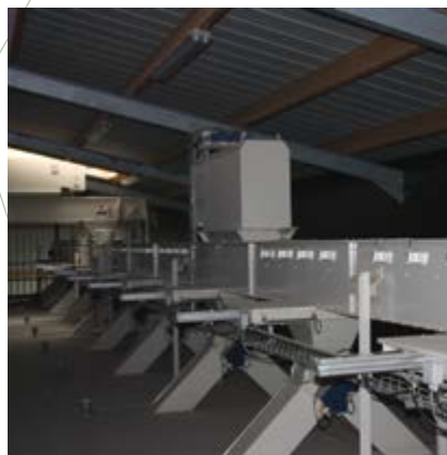
Silos de stockage
